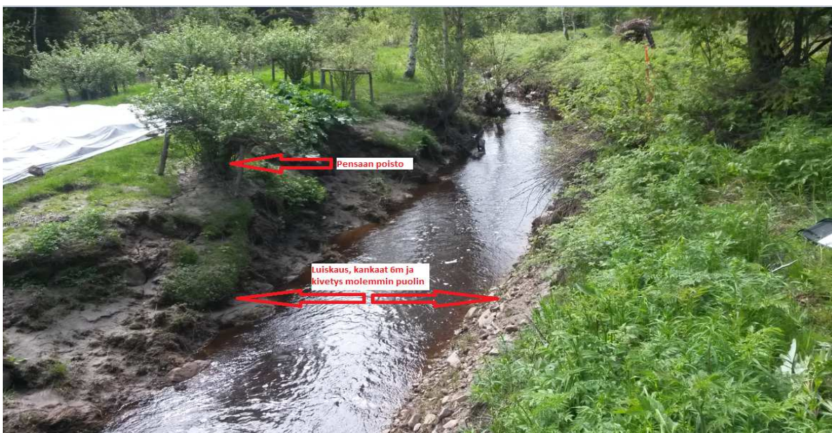
Kuva 14. Kohdenumero 7 (Pensaan poisto 69m kohdalla)
