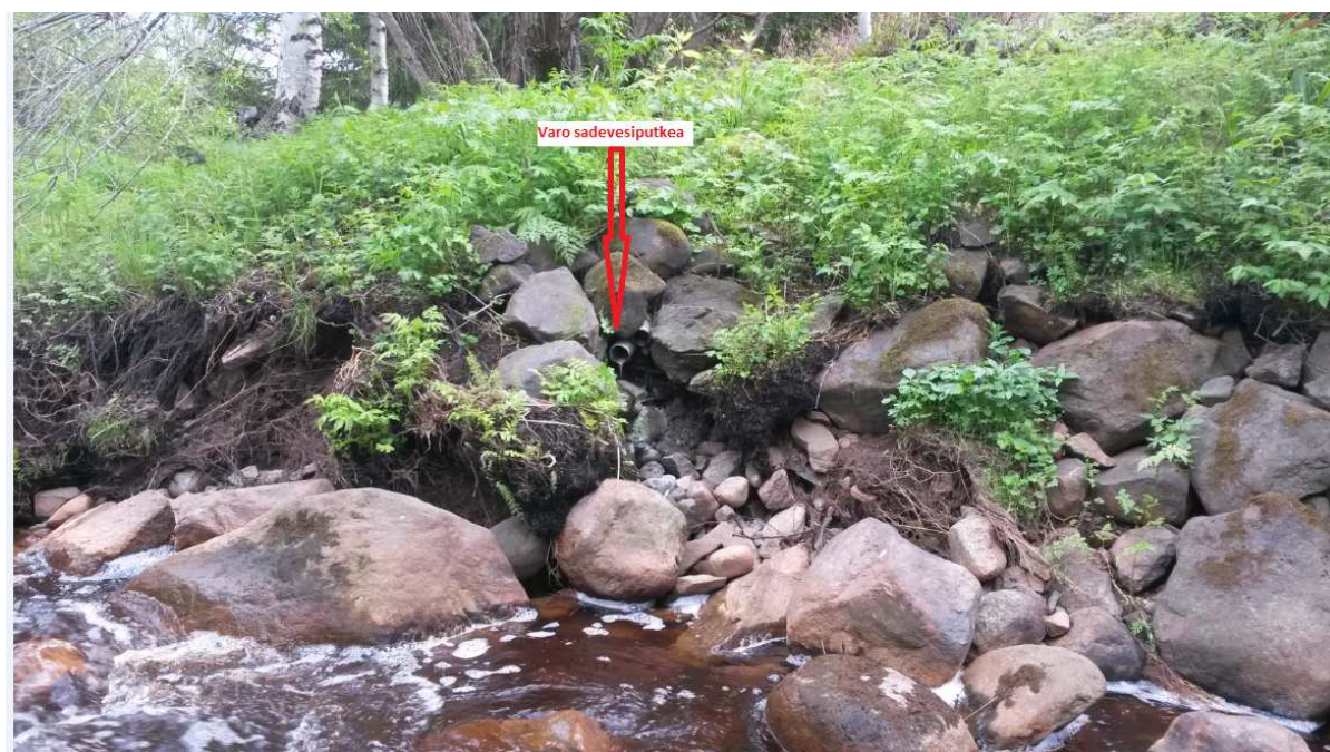
Kuva 5. Kohdenumero 1 (Sadevesiputki 4m kohdalla)
